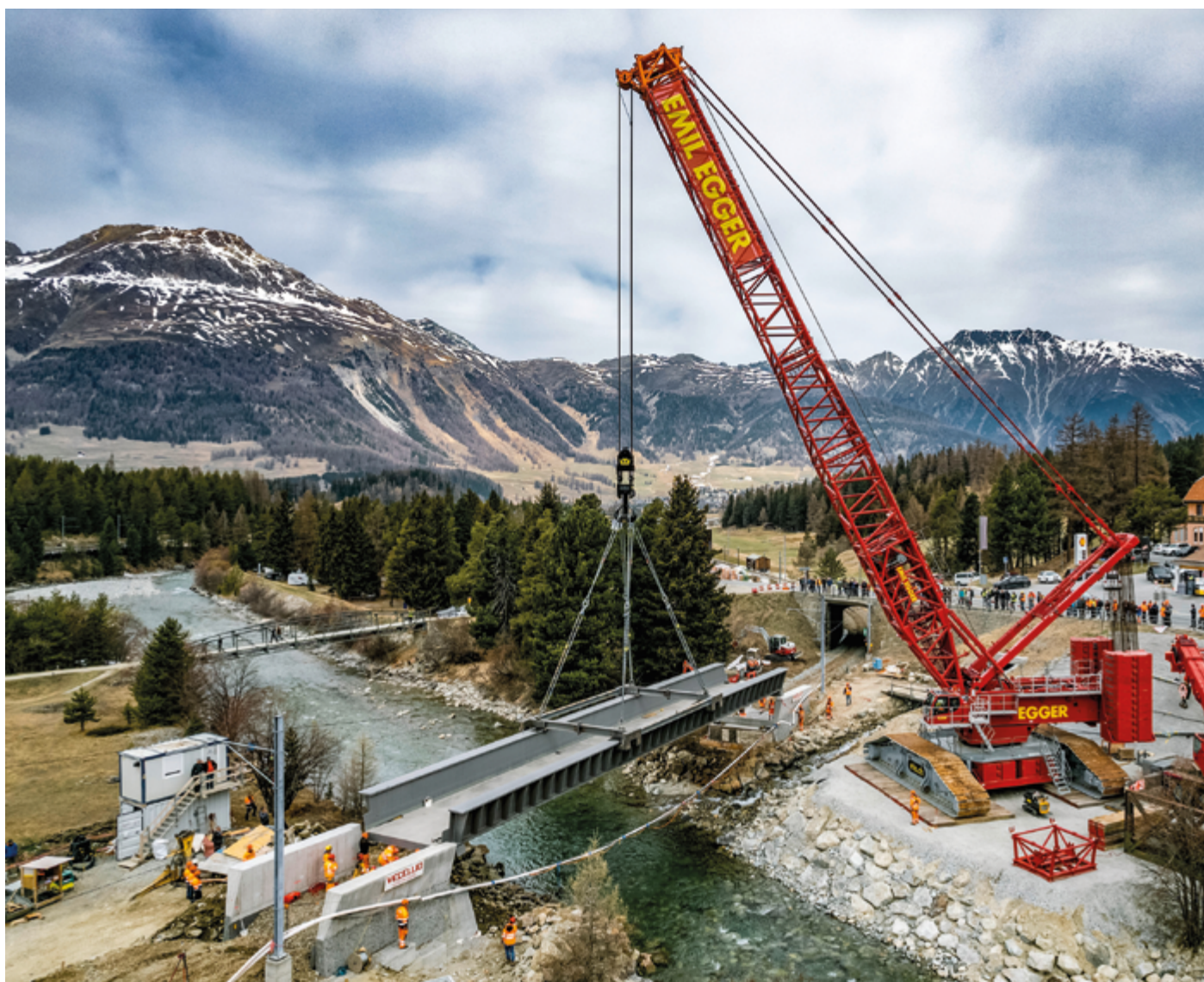
Immagine: sollevamento del ponte Flazbach, ETE
