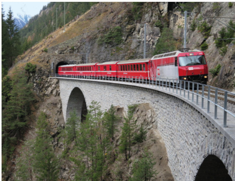
Bild: Stulsertobelviadukt, Karl Baumann
