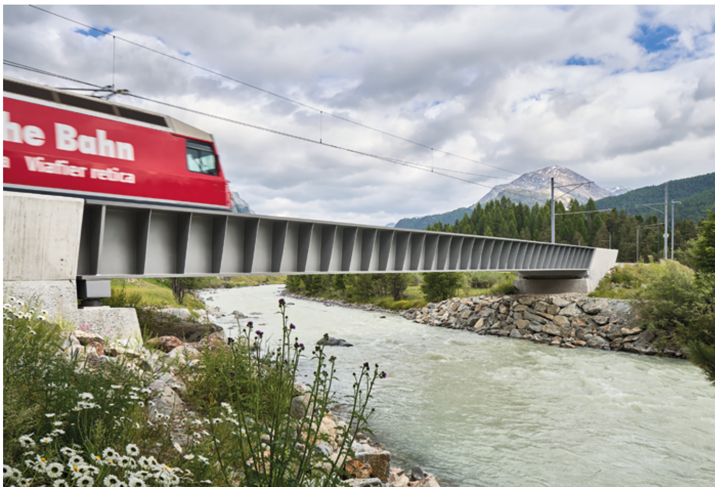
Bild: Flazbrücke in Punt Muragl, Ralph Feiner
