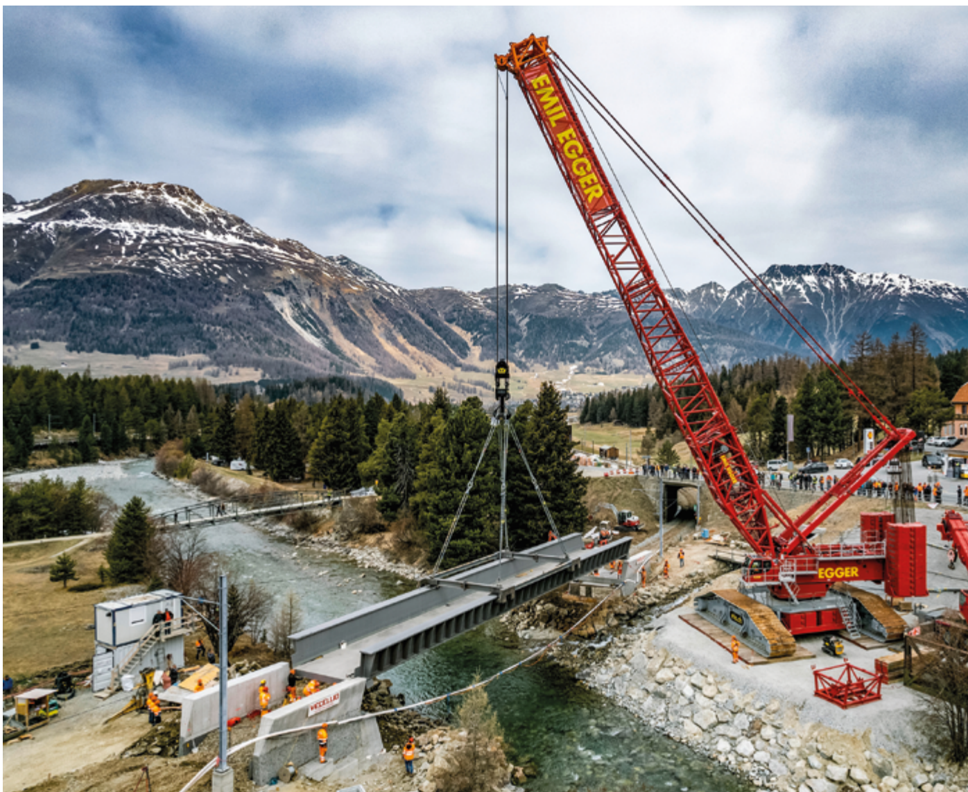
Bild: Einhub Flazbachbrücke, Bild ETE
